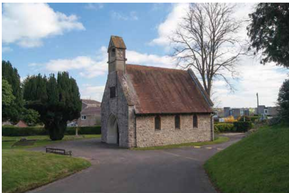
10. Înregistrarea clădirii. Fotografii exterioare. Fațadă Sud-Vest.
