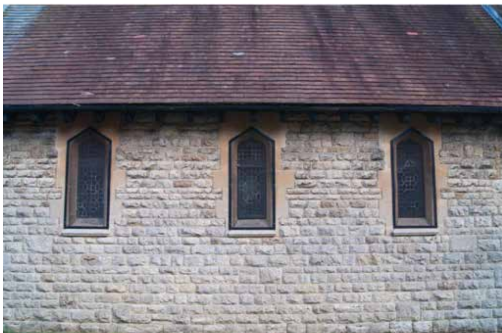
12. Înregistrarea clădirii. Fotografii exterioare. Detaliu fațadă Sud.
