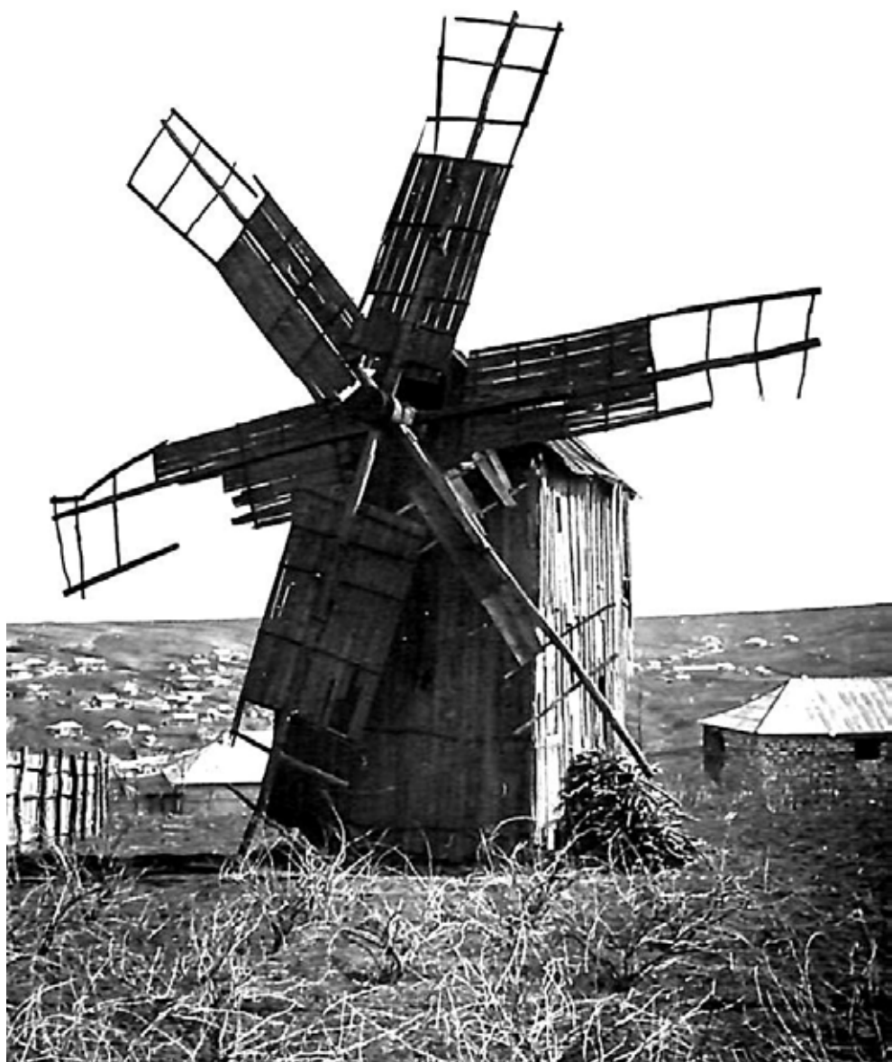
23. Moară de vânt (construită din lemn). Satul Costești, raionul Ialoveni. Sursă: ASCASM 1972. Fondul 24-2-13. Отчет о полевых исследованиях в 1971—1972 гг. в Страшенском, Котовском и Криулянском районах МССР по хозяйственной тематике, выполняемые для Реставрационных мастерских Министерства культуры МССР. Отдел Этнографии и Искусствоведения Академии Наук Молдавской ССР.
