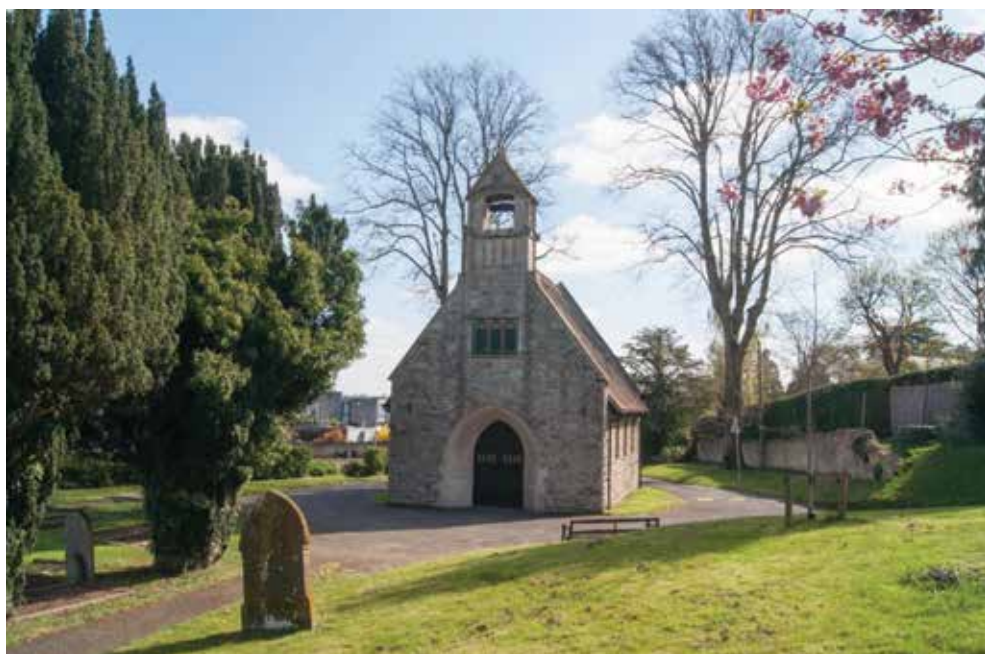
11. Înregistrarea clădirii. Fotografii exterioare. Fațadă Vest.
