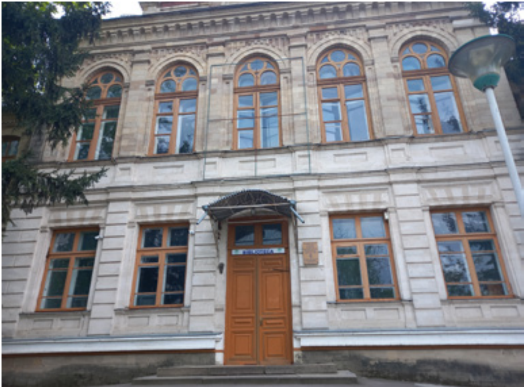
Рис. 3. Здание одного из корпусов Кишиневского государственного университета, расположенного сегодня на углу улиц Пушкина и Когылничану. Фото автора
