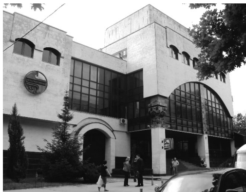
Рис. 11. Здание КБ “Moldindconbank” – 1995 г. – постмодернизм
