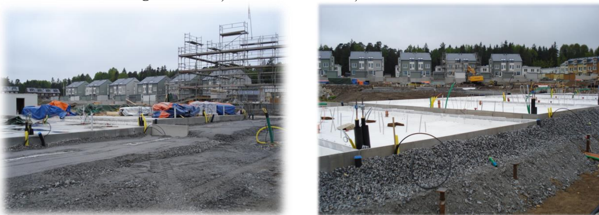
Figura 3. Lanțul suprastructură, șantier or. Stockholm, Suedia
